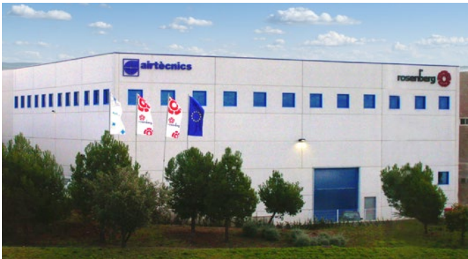
Seu d'Airtècnics a Castellar del Vallès (Barcelona)
