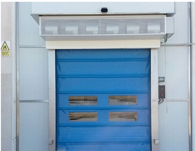
Fly KXL Instal·lació en porta de servei de fàbrica de llegums
