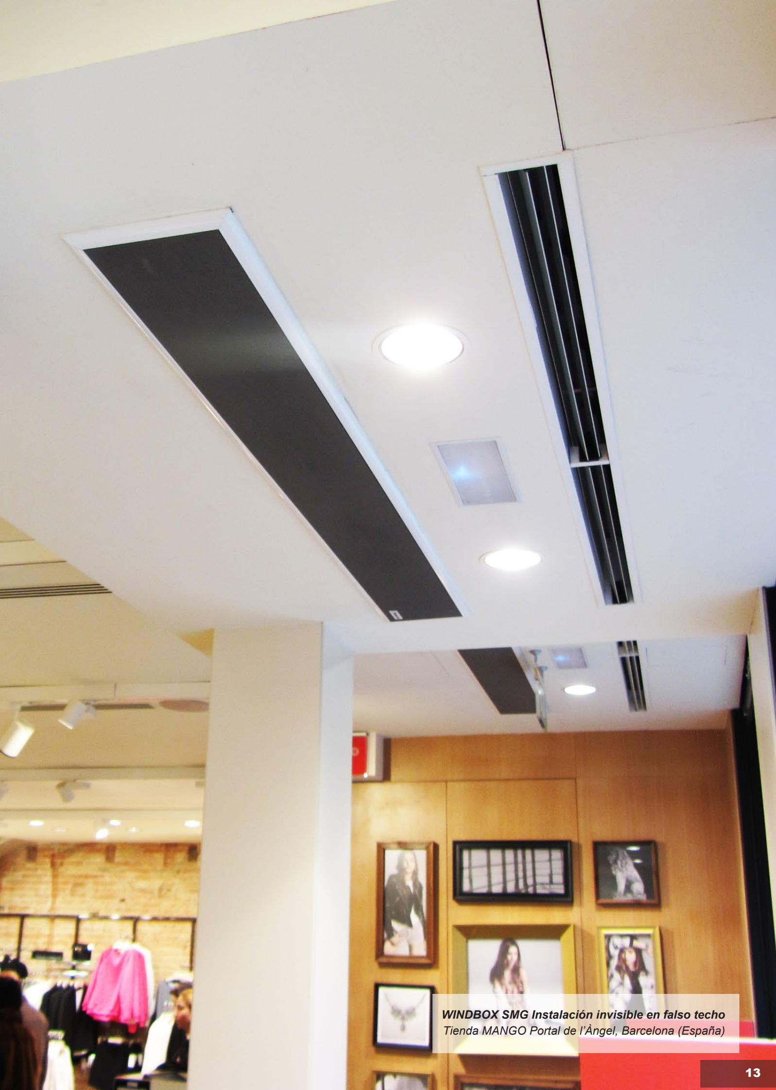
**WINDBOX SMG** Instalación invisible en falso techo
