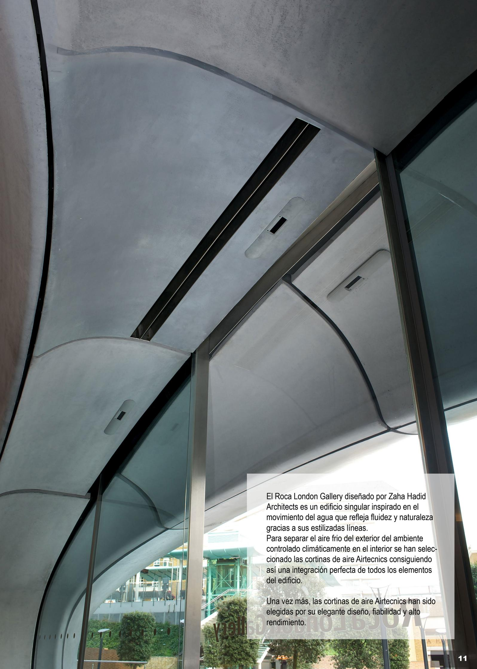
El Roca London Gallery diseñado por Zaha Hadid Architects es un edificio singular inspirado en el movimiento del agua que refleja fluidez y naturaleza gracias a sus estilizadas líneas. Para separar el aire frío del exterior del ambiente controlado climáticamente en el interior se han seleccionado las cortinas de aire Airtecnicos consiguiendo así una integración perfecta de todos los elementos del edificio.
