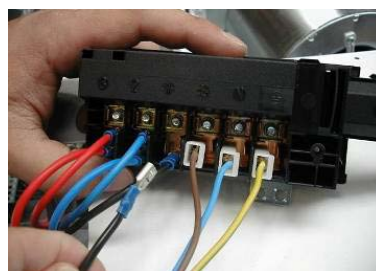
Desconecte los cables 1, 2, 3 de la caja conexiones.
